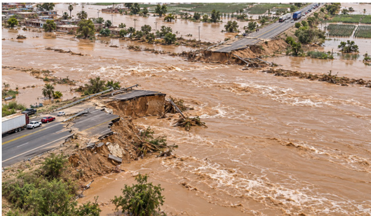
Figura 13. Escenario ilustrativo de potencial daño en la zona norte: desborde fluvial, colapso de la plataforma vial e inundación de áreas urbanas y agrícolas.
