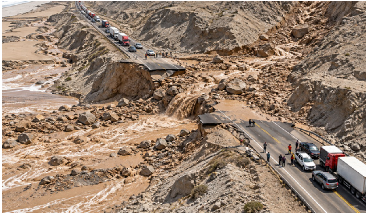
Figura 15. Escenario ilustrativo de potencial daño en la zona sur: flujo de detritos, caída de roca y corte de la Panamericana Sur.
